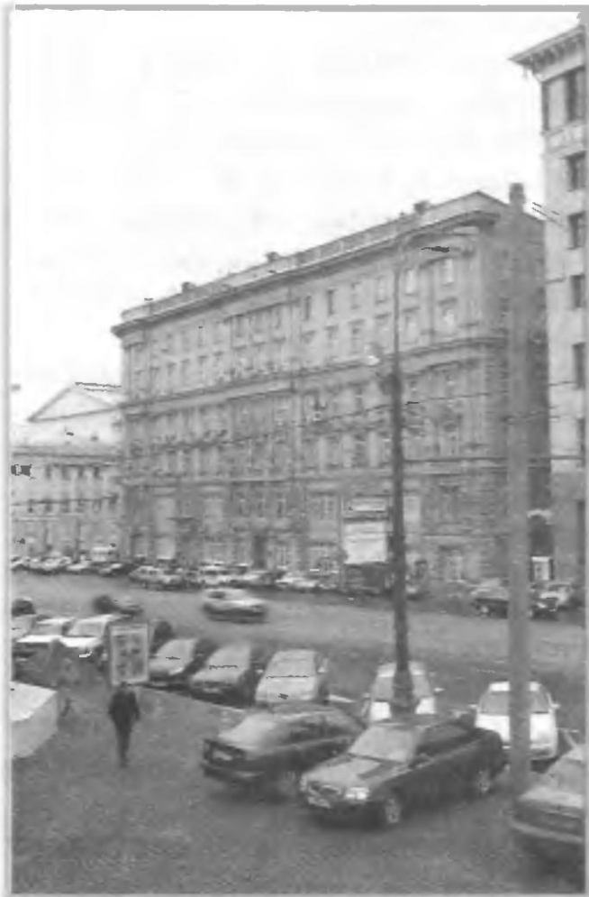
Фасад здания МЧС
